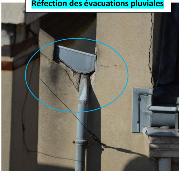
Réfection des évacuations pluviales
