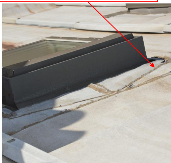
Défauts de raccordements sur les points singuliers de la zinguerie
