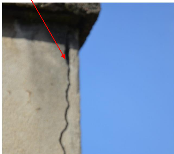
Sortie en fibre amiante ciment désolidarisée du scellement « risque de chute » coté cour
