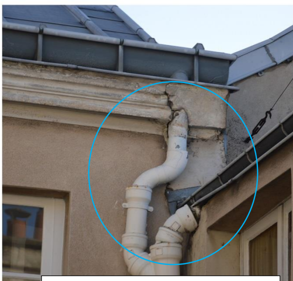
Réfection des évacuations pluviales
