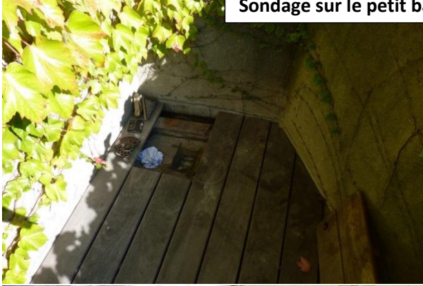
Sondage sur le petit balcon R+1 côté droit (basse pente)
